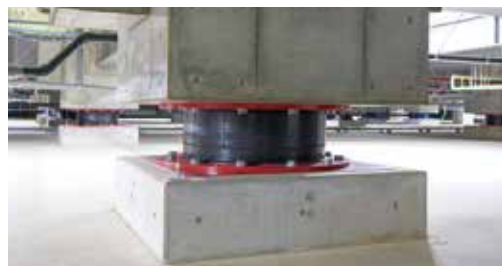
鉛プラグ入り積層ゴムアイソレータ
