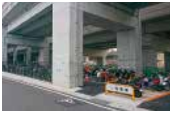
▲上熊本駅駐輪場
