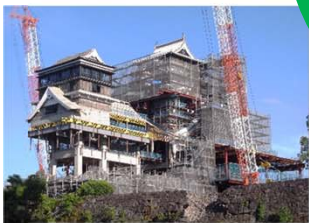
復旧中の熊本城
