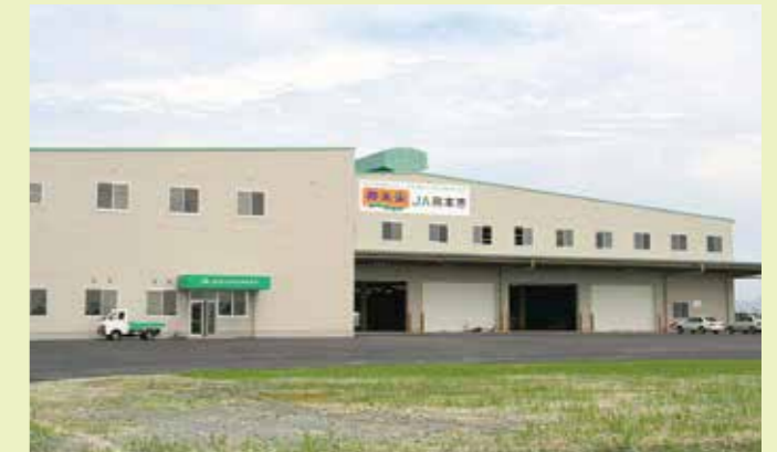
野菜の集出荷貯蔵施設（熊本市南区会富町）
