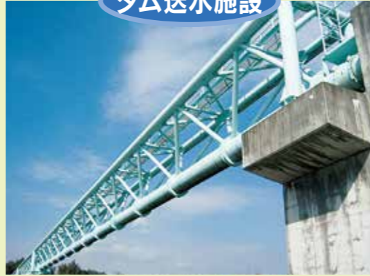
ダム送水施設
