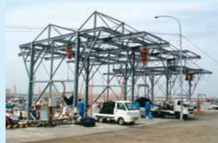
省力化、利便性を考慮した漁港の整備（四番漁港）
