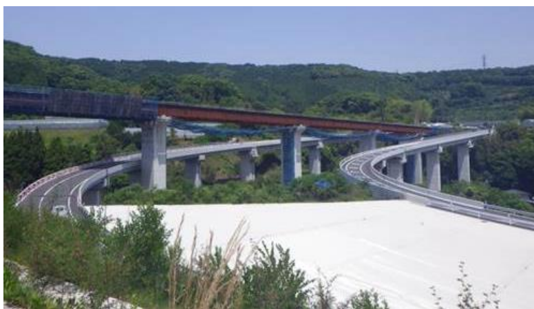
熊本西環状道路 池上工区花園高架2号橋
