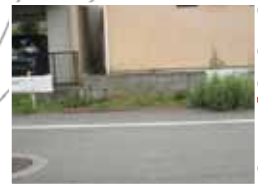
大雨時、転落防止の柵なし、危険あり
