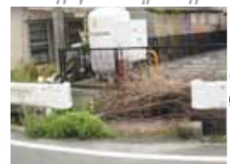
大雨時、転落防止の柵なし、危険あり
