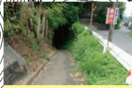
急勾配な階段でガケくずれ危険
