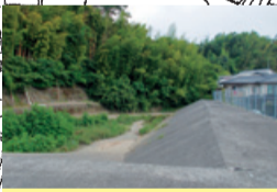
新津浦団地の調整池 旧3号線の水が集中し危険
