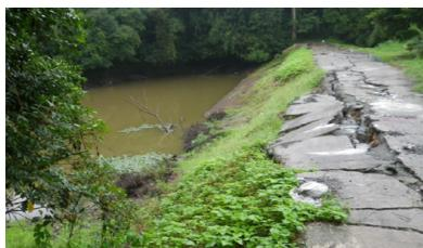
鬼ため池(下池の堤体)における亀裂発生の様子
