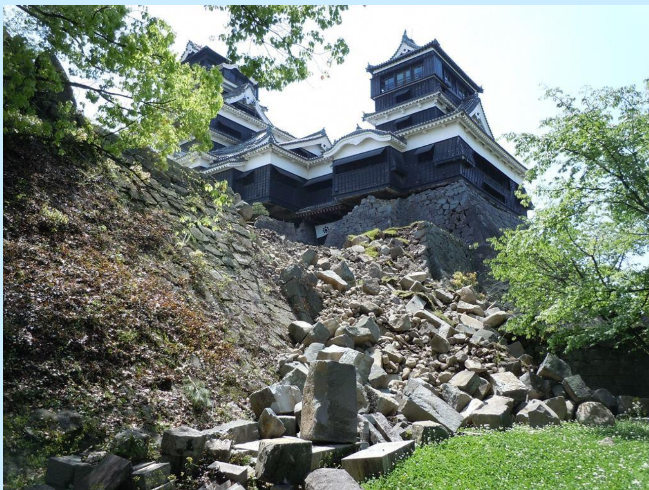
【平成 28 年熊本地震により被害を受けた熊本城天守閣】
