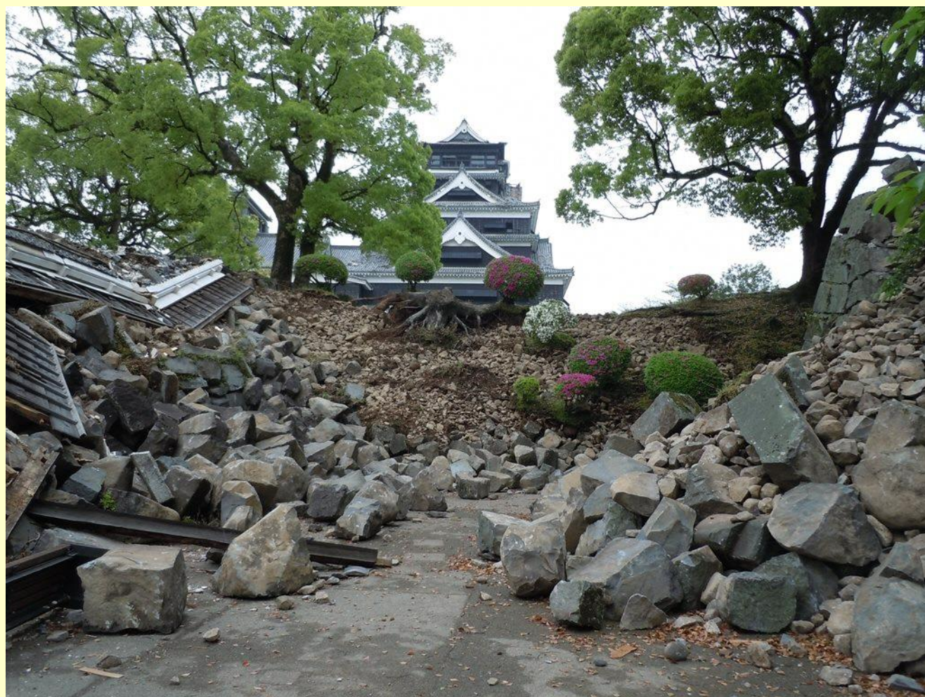
【平成 28 年熊本地震により被害を受けた熊本城頼当御門周辺】
