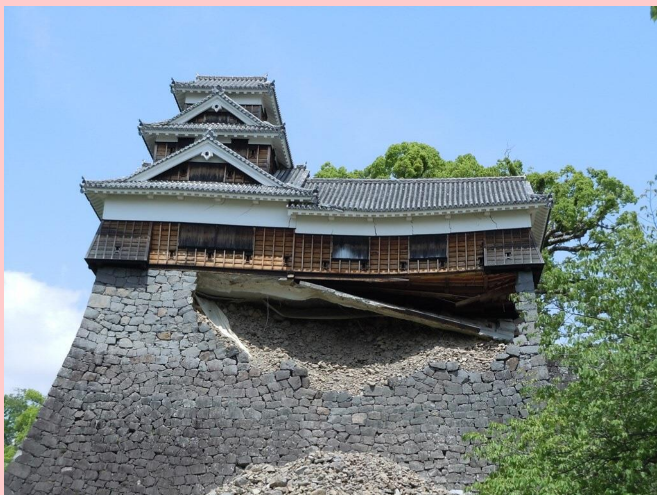
【平成28年熊本地震により被害を受けた熊本城飯田丸五階櫓】
