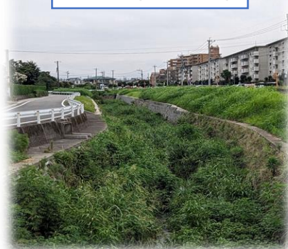
藻器堀川(河川工事中)
