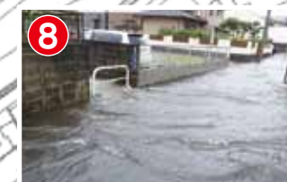
大雨時に水路があふれ 道路が冠水する
