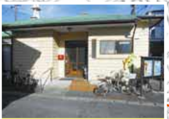
月出2町内公民館 (防災倉庫・防災用品・ 一次避難場所)
