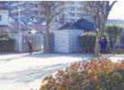
西油称公園 (防災倉庫) (テント・防災用具)
