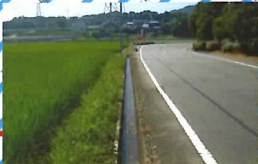
フタのない、側溝
