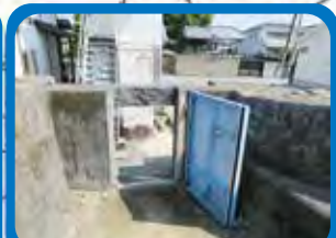
④水門(樋門)
