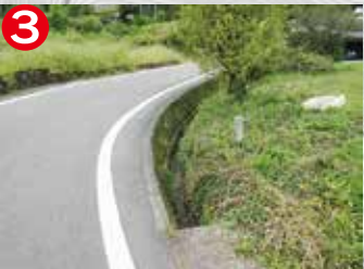
フタのない水路
