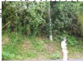
大雨時 崖崩れの恐れ
