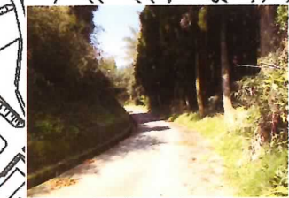
大雨時用水路注意 (ふたがない)
