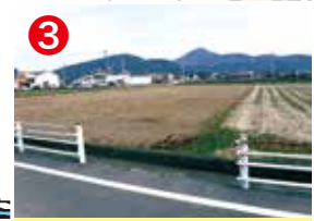
水路にガードパイプなし
