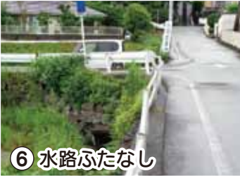
⑤ 土砂崩落 近づかない
