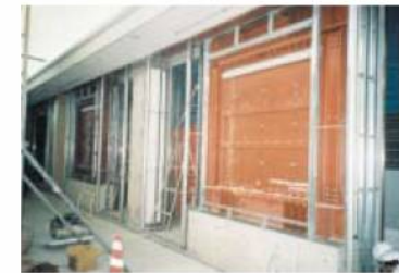
制振補強の例(粘性壁の追加)
