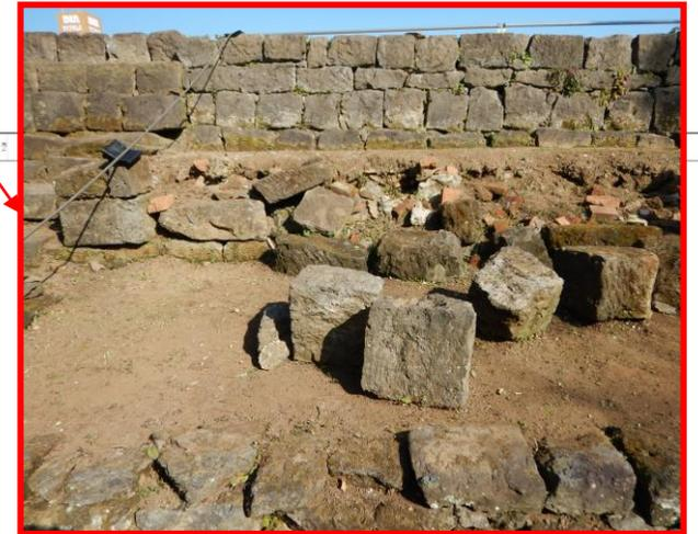
※被災して築石背面裏込め露出。モルタル付き煉瓦含む
