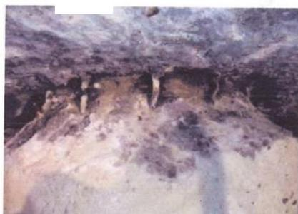
図16 場所打ち杭の被害例（杭径は1.1mか1.2m）
