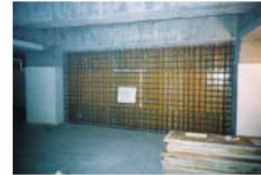
耐震補強の例(耐震壁の追加)
