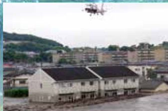
▲H24.7出水時の被害状況 (龍田陳内地区)
