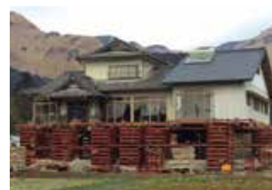
▲浸水被害から家屋を守る工事 (阿蘇市)
