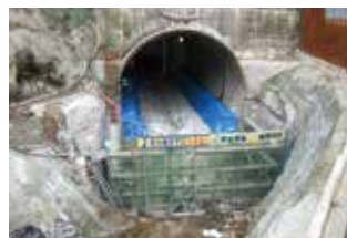
▲川の流れを切り替える工事 (立野ダム)
