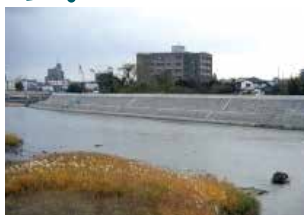
▲築堤工事(黒髪地区)
