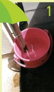
1 雨どい(塩化ビニール管)の下の配管を外す
