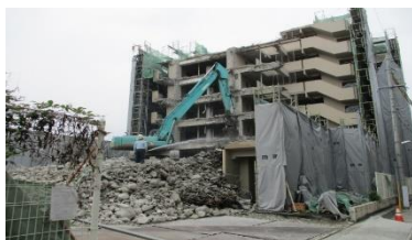
▲ 被災家屋の解体・撤去
