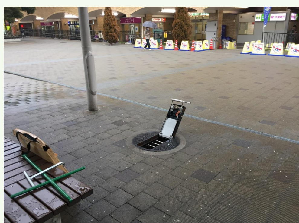
マンホールトイレ(吹田駅)
