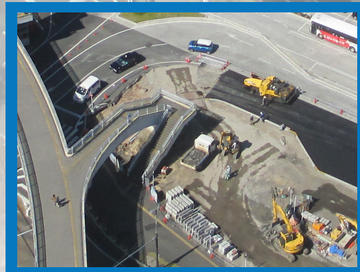
整備前の歩道橋階段
