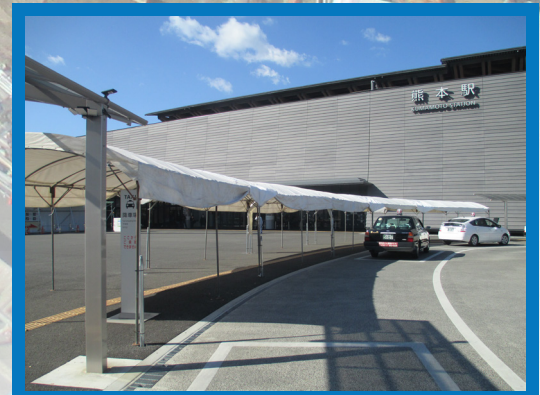
追加設置された仮屋根
