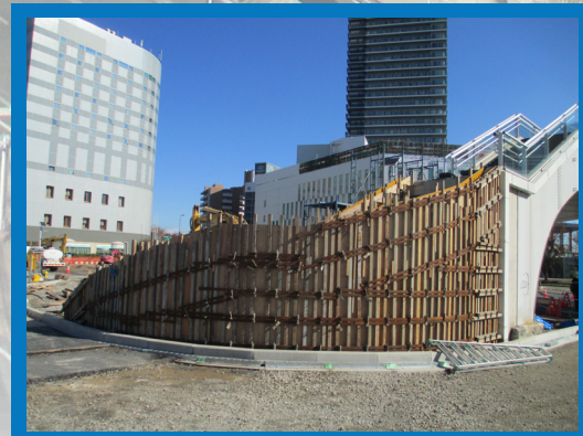
躯体部分のコンクリート型枠
