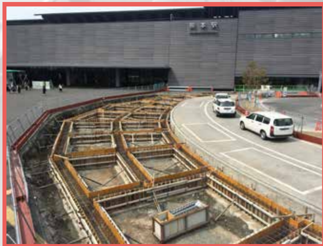
屋根の基礎工事中。
