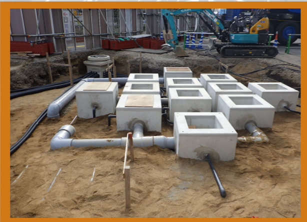
埋設物工事の状況
