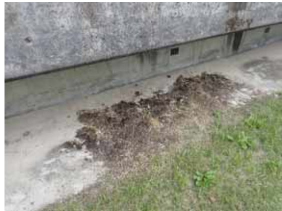
東部浄化センター内のため糞
