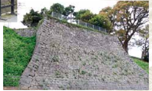
▲明治8年頃陸軍病院玄関前に築造された「清正流石垣」
