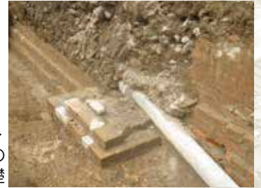
旧合同庁舎確認調査時の 煉瓦倉庫基礎
