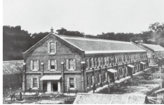
▲陸軍兵器廠煉瓦倉庫 行幸坂から桜馬場方面を望む風景。 〔熊本日日新聞社提供〕
