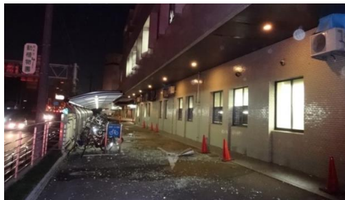
市民病院南館2階検査部門窓破損落下
