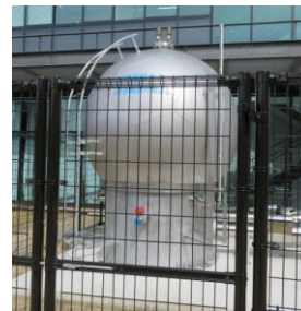
▲ 貯水機能付給水管 (地震などの災害時に起こる断水に備えて水を貯めることができる)
