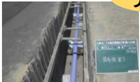
被災管渠の布設替えによる復旧
