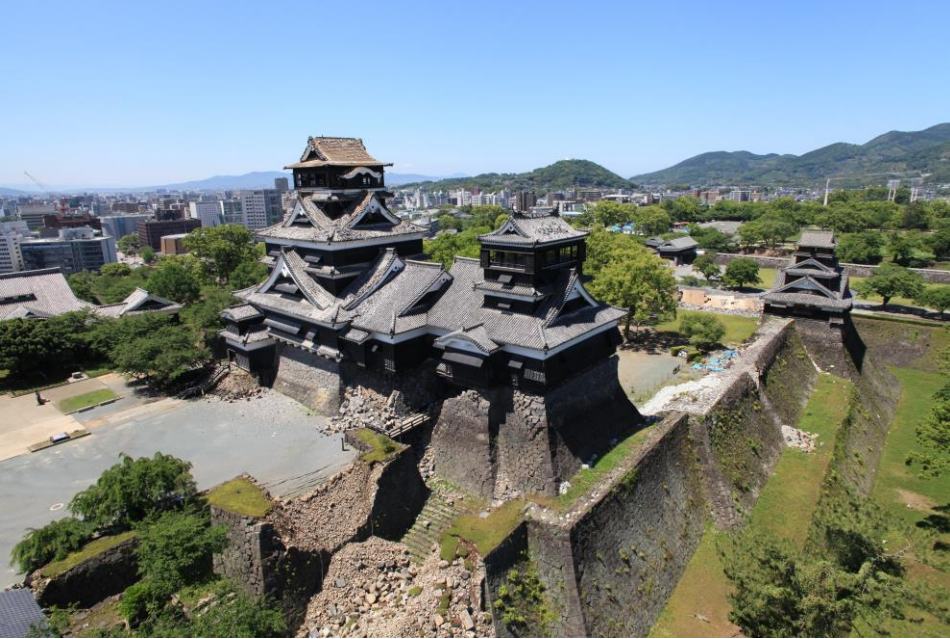
大小天守の破損と石垣の崩落
