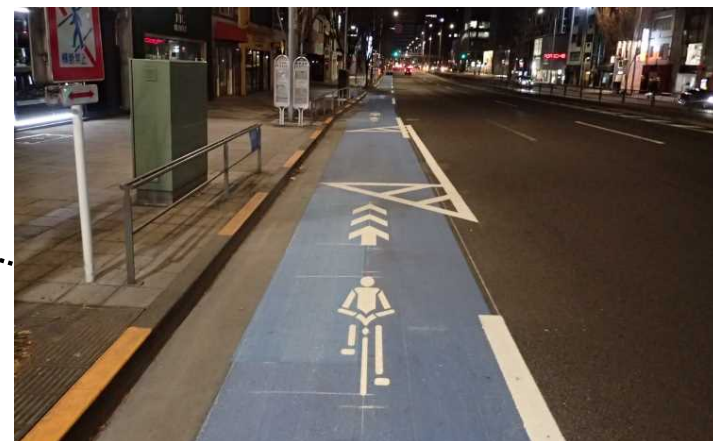
国道246号（青山地区）
