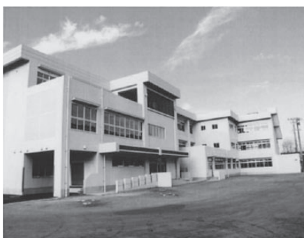
【河内小学校校舎】
