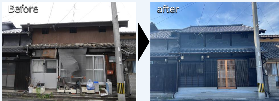
町屋（小沢町）外観改修工事
