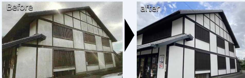
一般建造物（川尻1丁目）外観改修工事
