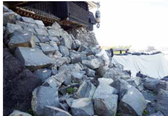
▲崩落した小天守石垣石材を回収
