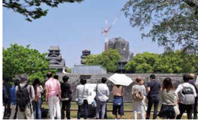
▲二の丸広場から大天守鯉瓦の取付けを見守る市民(平成30年4月)
