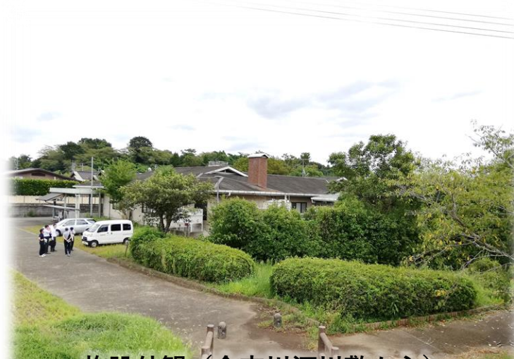
施設外観（合志川河川敷から）
