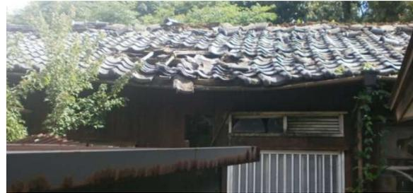
屋根ぶき材に著しい剥落があり、軒が垂れており、屋根全体の変形の予兆がある例
