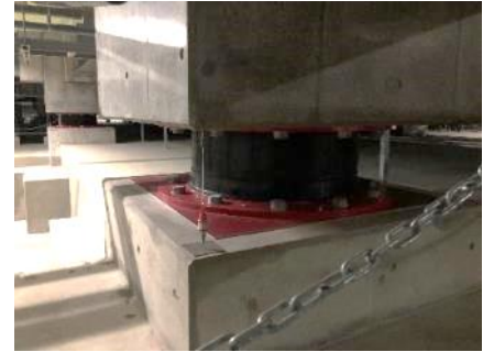
耐震性能の向上の例（免震構造）
