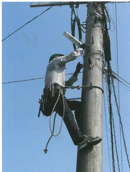
電柱に取り付けられるLEDの防犯灯 ＝八景水谷3丁目の村上商店前
