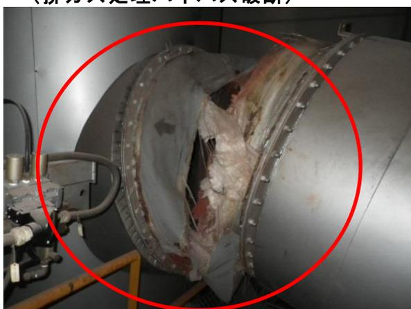
（炉冷却用配管破断）
