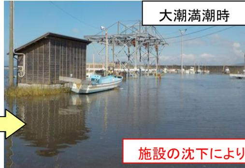
施設の沈下により冠水
