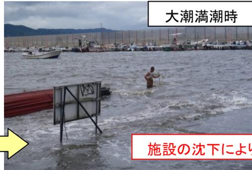
施設の沈下により冠水
